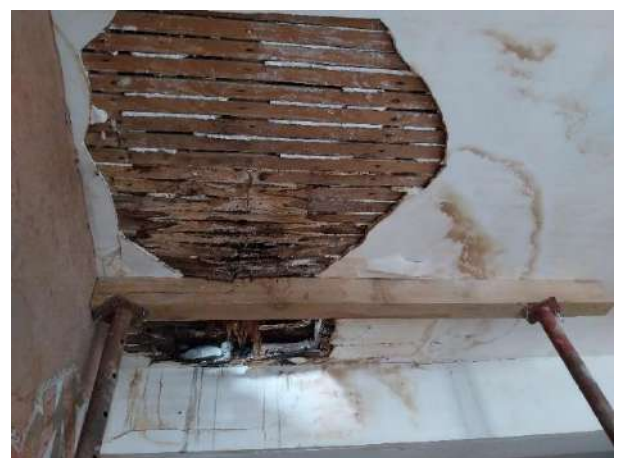
Plancher bois avec faux plafond en lattis bois + plâtre comprenant solivage et porteuse bois
