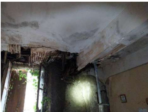
Plancher bois avec faux plafond en lattis bois + plâtre comprenant solivage et porteuse bois
