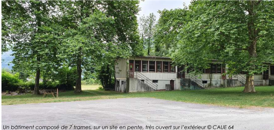
Un bâtiment composé de 7 trames, sur un site en pente, très ouvert sur l'extérieur © CAUE 64
