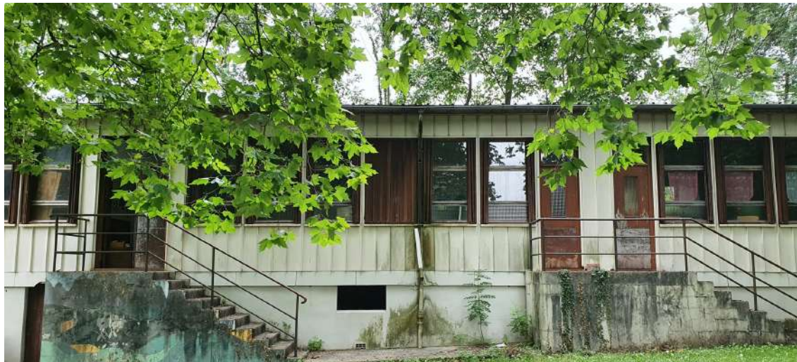
Une façade Sud très ouverte et protégée du soleil en été par les banchages © CAUE 64
